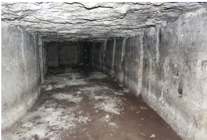
Рис. 4. Фрагмент каменоломни Булганакская-8б. Вид штольни после второго поворота, на забой. Фото: Сохин М., 2025
