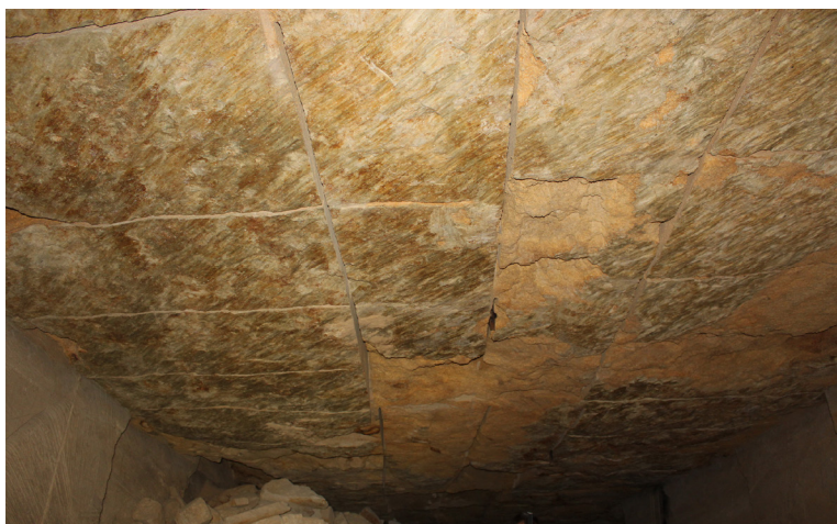
Рис. 12. Свод каменоломни Булганакская-11, образованный поверхностью висячего крыла сместителя, по которому осуществлялся отрыв блоков. Фото: Сохин М., 2025
