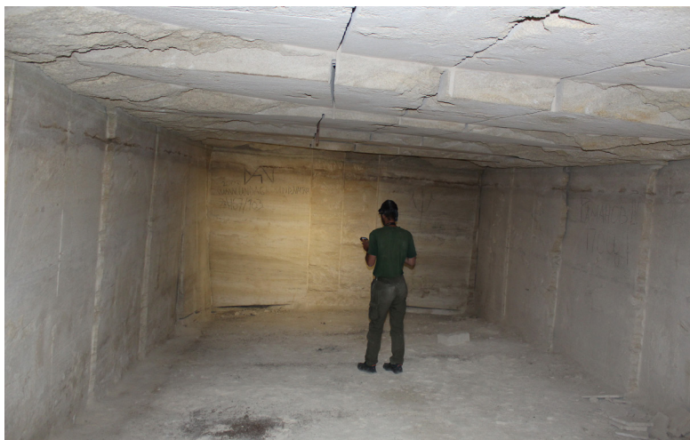
Рис. 13. Каменоломня Булганакская-11: расчищенный забой восточного штрека №6. Фото: Сохин М., 2025
