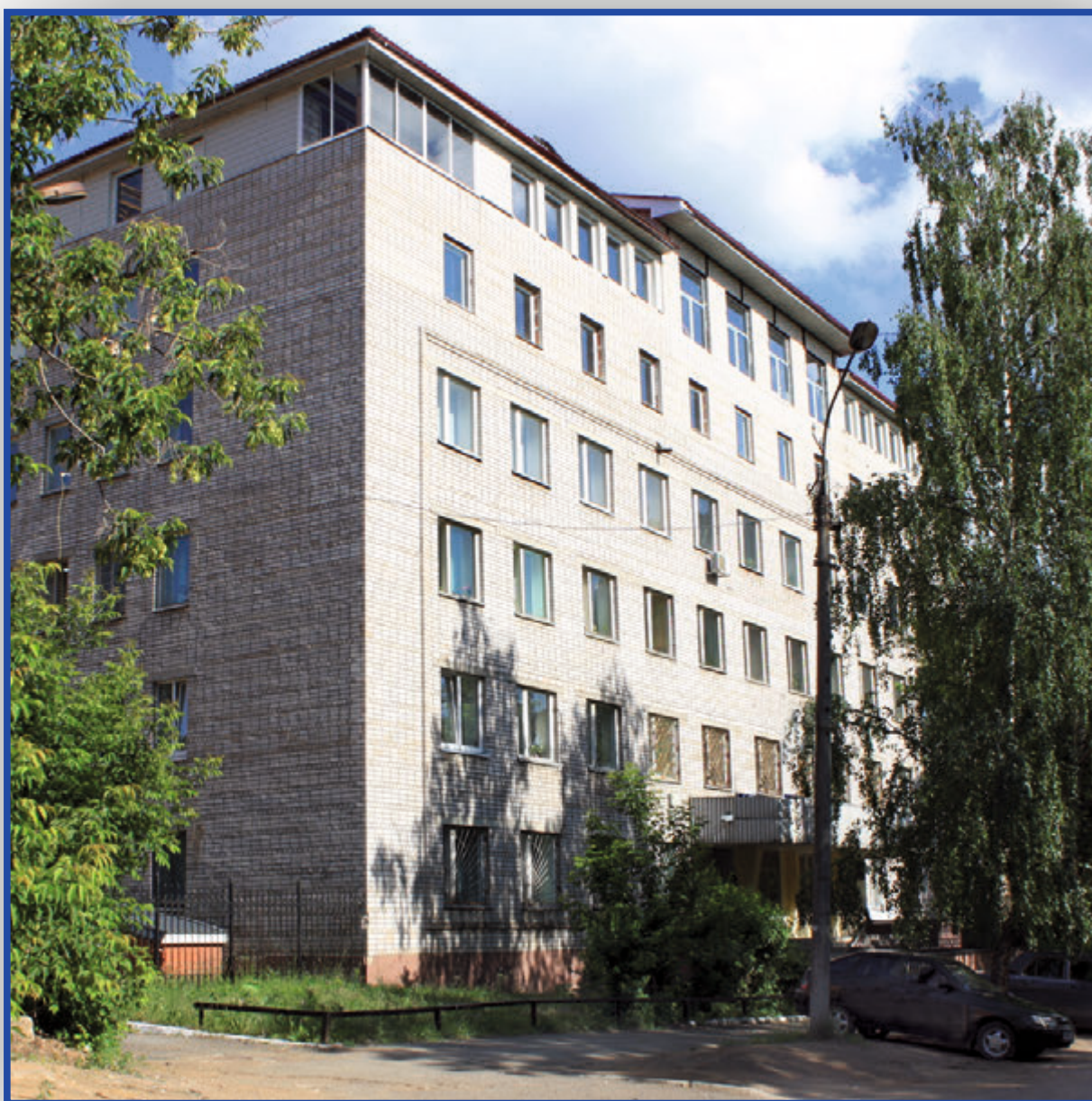
Здание Удмуртского института истории, языка и литературы УрО РАН
