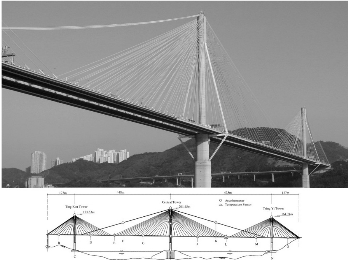
Рис. 8. Мост Ting Kau
