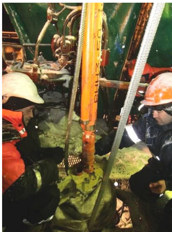
Рис. 12. Монтаж установки ОРЭ
