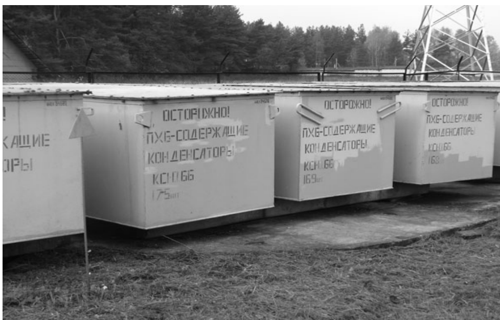
Рис. 3. Складирование ПХБ-содержащих материалов
