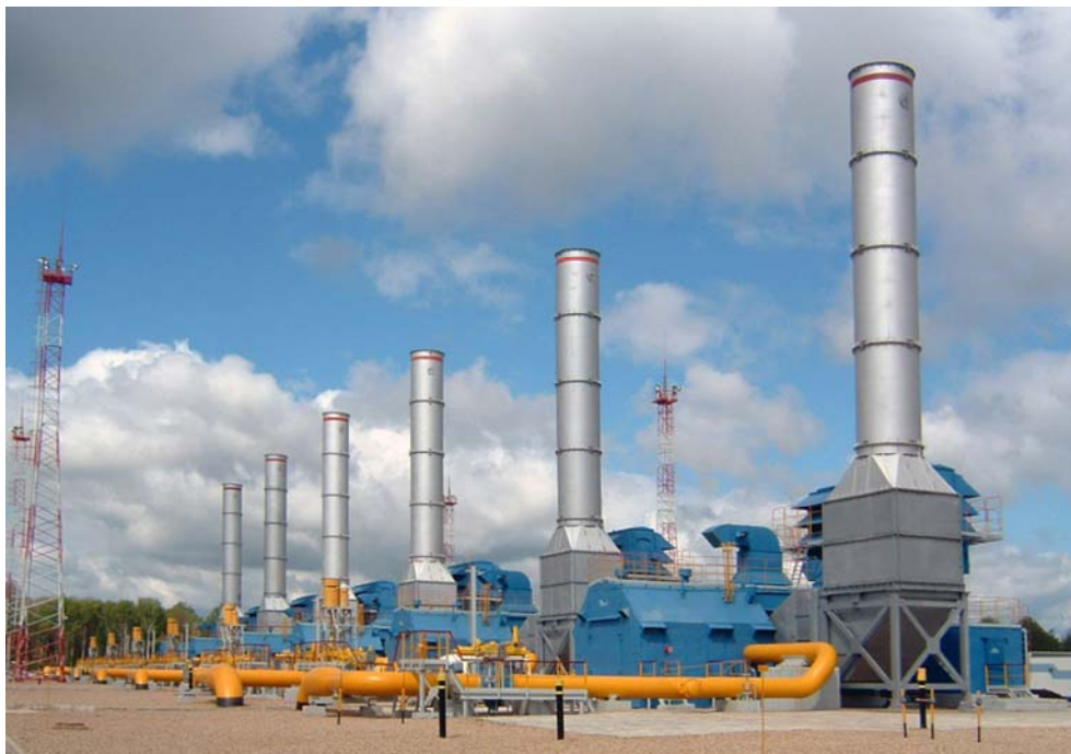
ГПА-16 серии «Урал» на компрессорной станции «Смоленская»
