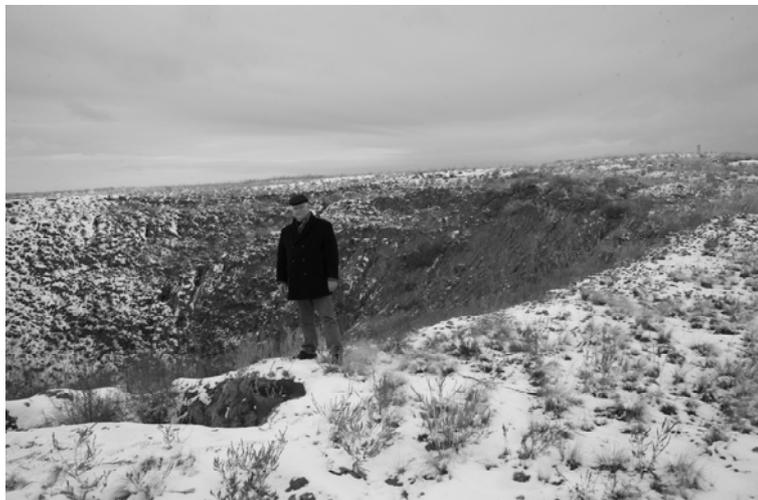
*Устья одной из скважин на площадке «Балапан». Видна воронка, образовавшаяся из-за просадки грунта после проведения подземного ядерного взрыва*
