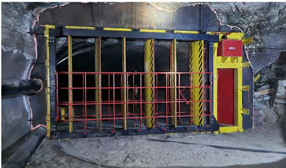
Рис. 1. Автоматическая вентиляционная дверь в условиях рудника
