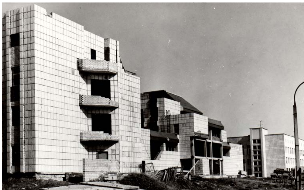
Строительство корпусов ИТХ
