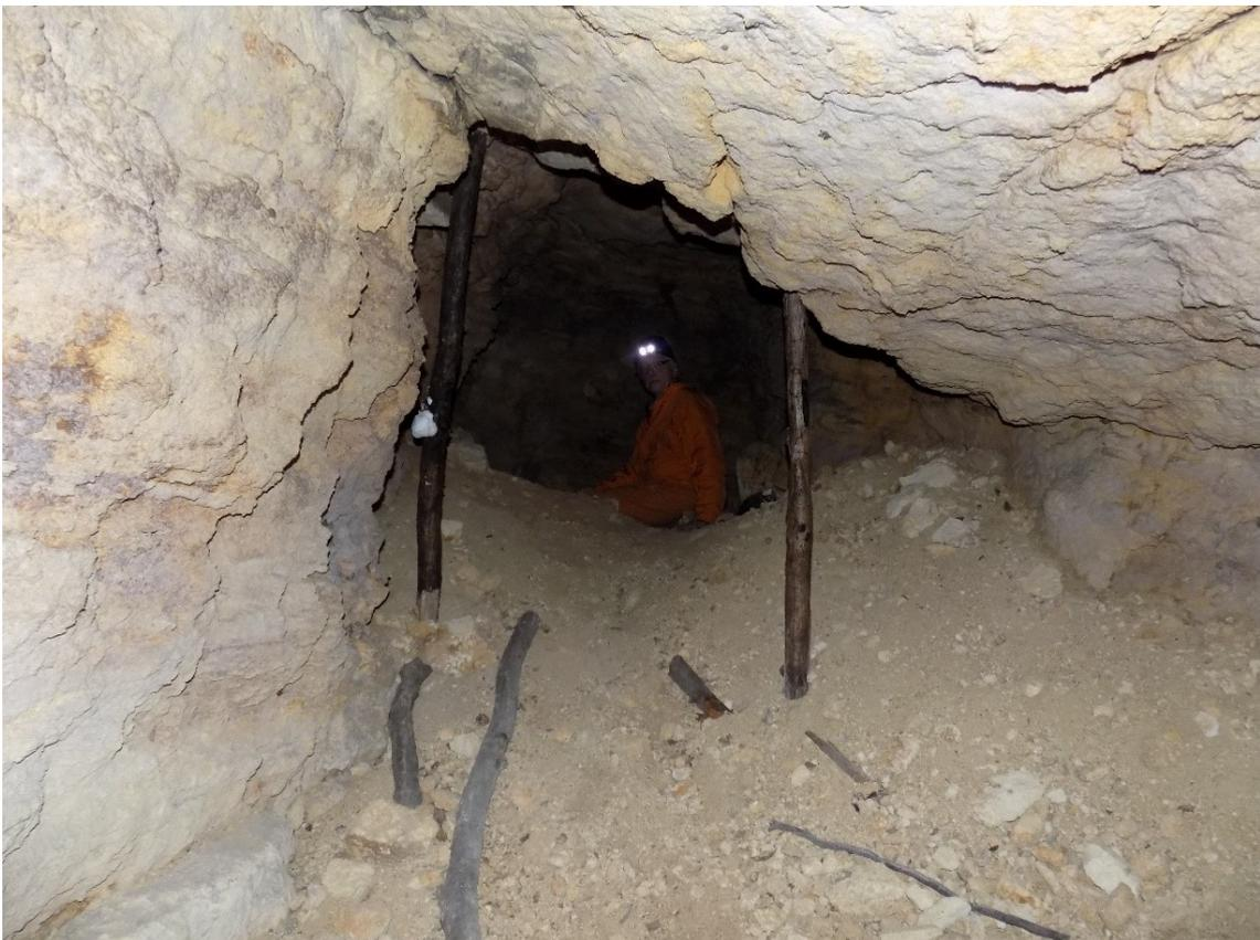
Рис. 9. Увеличение наклона кровли после тектонической трещины
