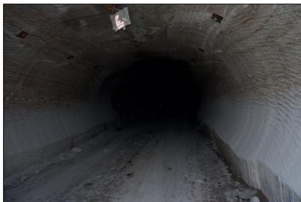
**Рис. 1.** Выработки, закрепленные анкерной крепью:
