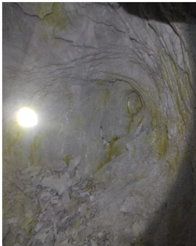
**Рис. 4.** Фотография стенок полости разрушения в забое технологической сбойки № 3 горизонта –630 м (подземный рудник «Удачный»)
