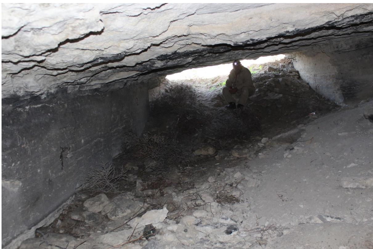
**Рис. 5.** Асимметричность стенок штольни в подземной выработке Яныш-Такильская-2
