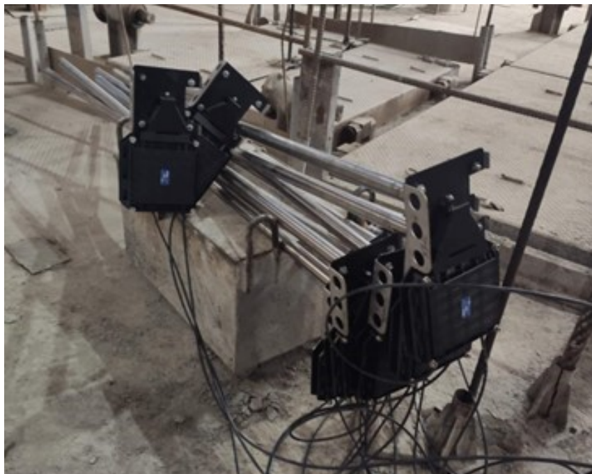
Рис. 1. Линия датчиков подготовлена к установке на нулевой отметке ствола
