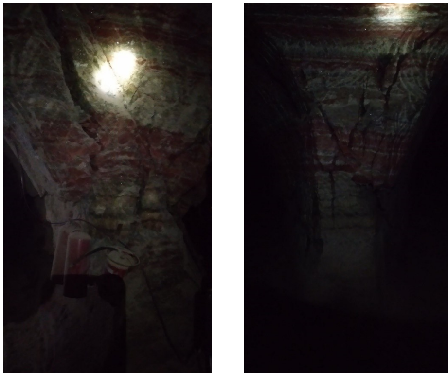
Рис. 2. Продольные трещины в целиках (вид с торцов)
