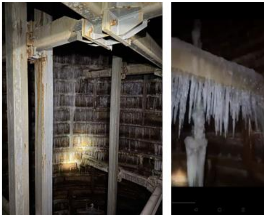
Рис. 2. Обмёрзшая тюбинговая крепь
