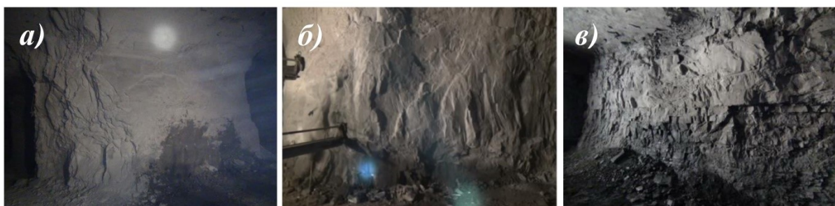
Рис. 3. Общий вид стенок междукамерных целиков: (а) панель 53; (б) панель 47; (в) панель 18
