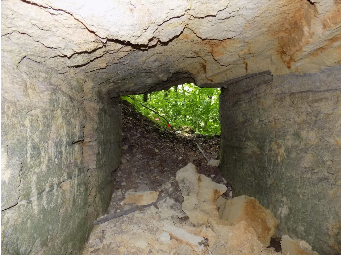
Рис. 8. Привходовой участок штольни
