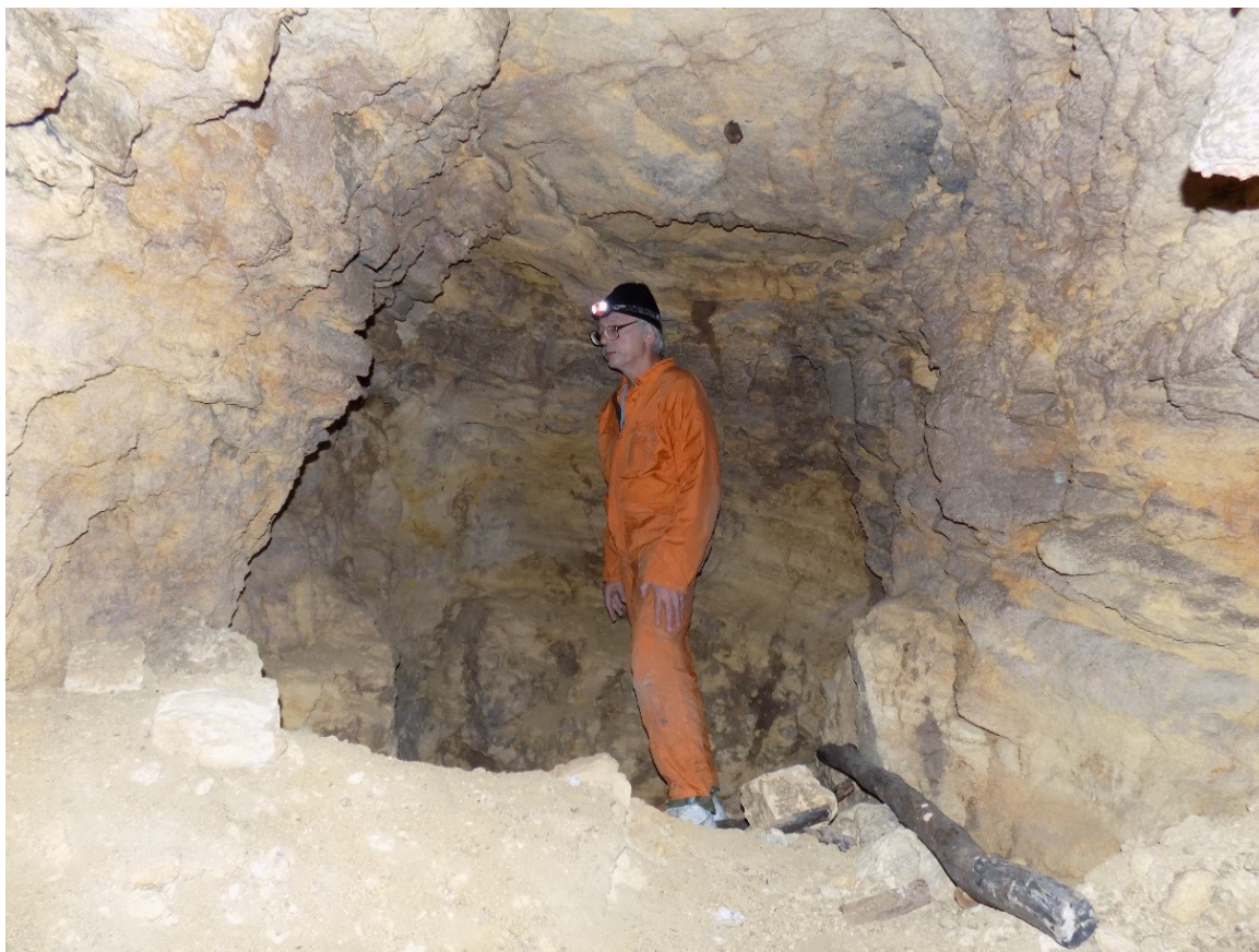
Рис. 10. Переработанный обвалами забой штольни
