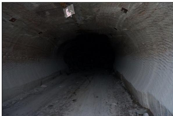
**Рис. 1.** Выработки, закрепленные анкерной крепью:
