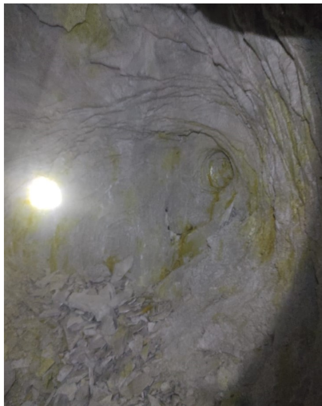
Рис. 4. Фотография стенок полости разрушения в забое технологической сбойки № 3 горизонта –630 м (подземный рудник «Удачный»)
